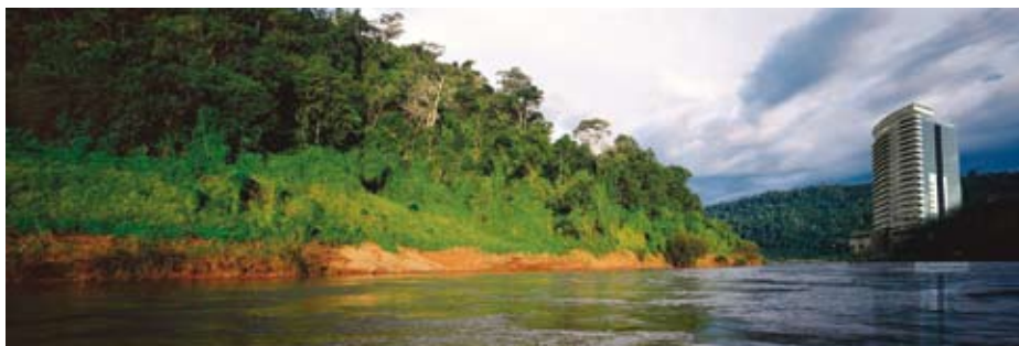
Diferentes perspectivas del montaje de un edificio sobre las costas de un río.
